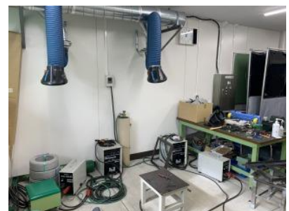
溶接スペース
