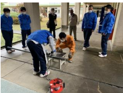
室外での作業
