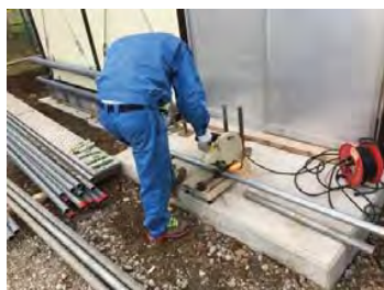
単管切り出し
